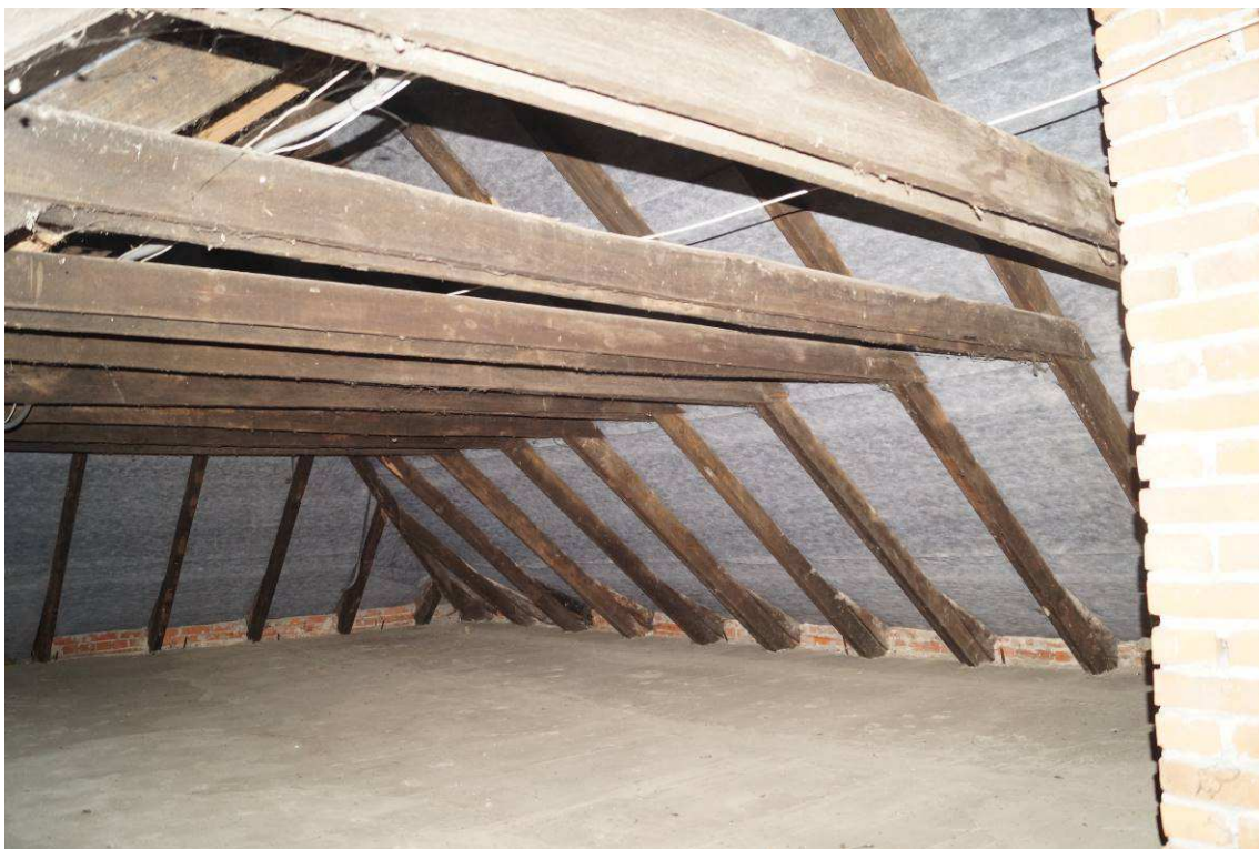
Więźba dachowa – nad II częścią
